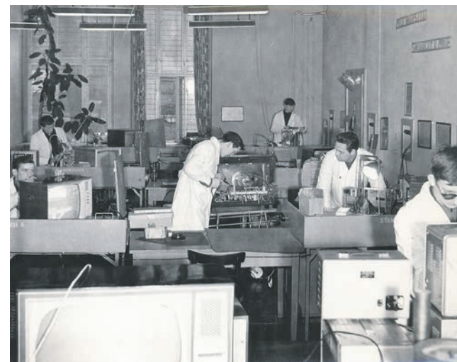
Hala napraw w zakładzie przy ul. Sienkiewicza
