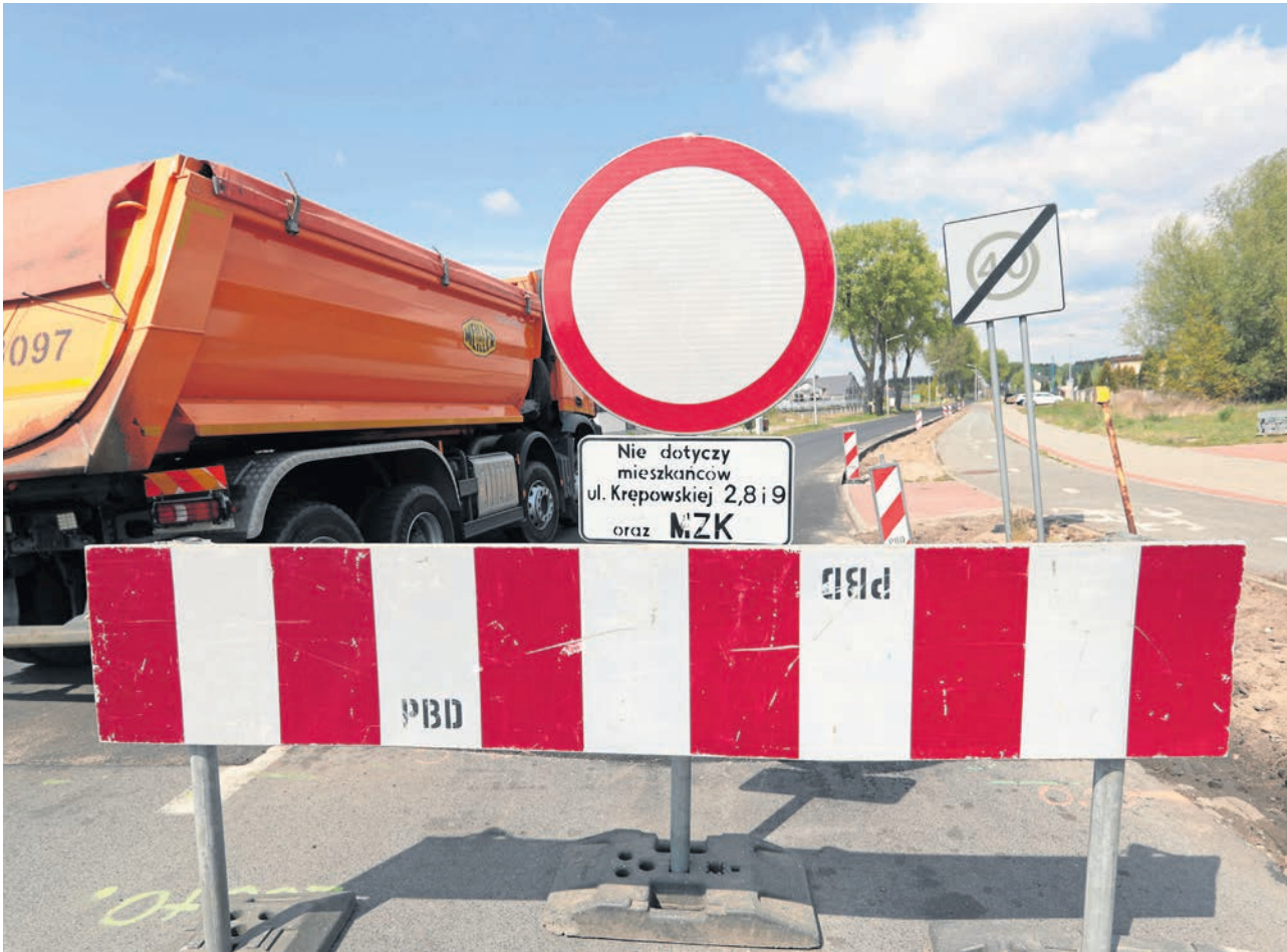
Trwa remont ulicy Krępowskiej - odcinka od pętli autobusowej przy ul. Truskawkowej na Chynowie do pierwszych zabudowań w Krępie
