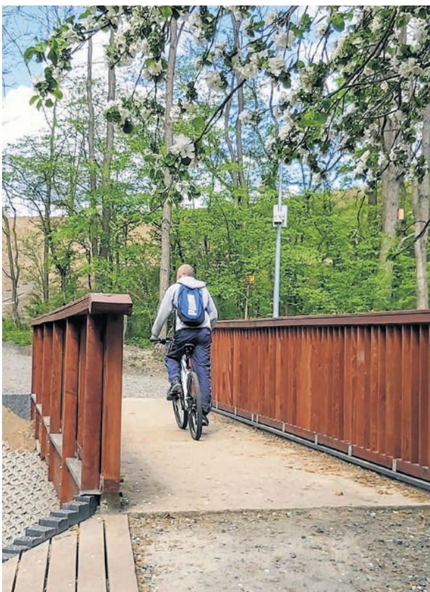
Przejście na drugą stronę rzeki umożliwiają mostki z drewnianymi balustradami
