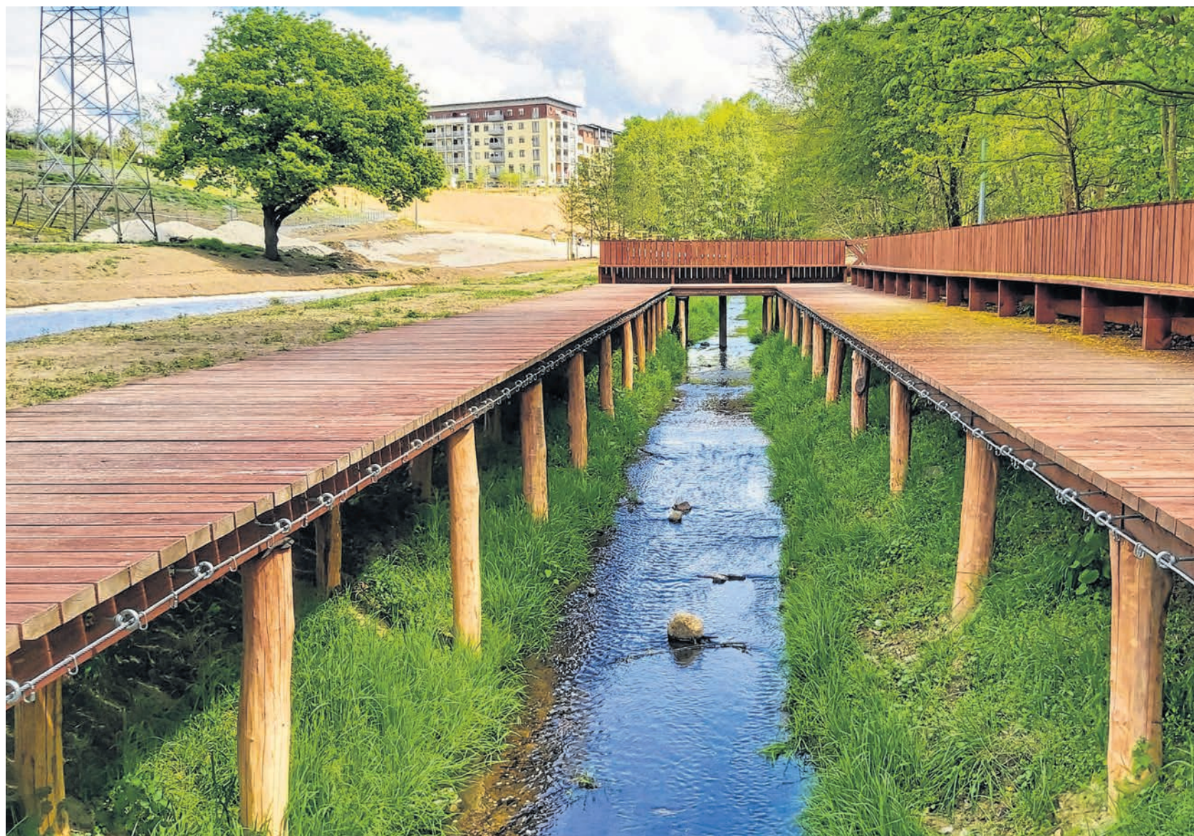
Pomiędzy pomostami, zbudowanymi z obu stron Gęśnika, zostanie rozpięta siatka, na której będzie się można położyć. Siatka pojawi się tuż przed odbiorem prac. To będą
