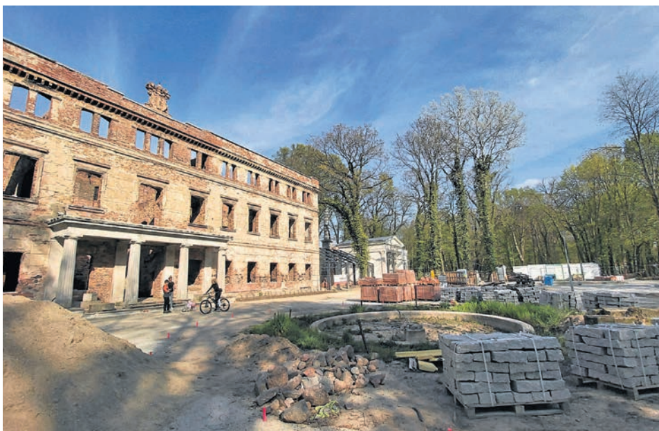
Teren wokół pałacu to wciąż plac budowy
