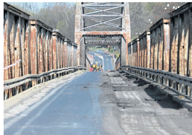
„Staruszek” nareszcie się doczekał! Pełną parą ruszył remont stoletniego mostu nad Odrą w Cigacicach. Od środy, 15 kwietnia, przeprawa jest zamknięta dla pieszych i zmotoryzowanych. Fot. Piotr Jędzura
