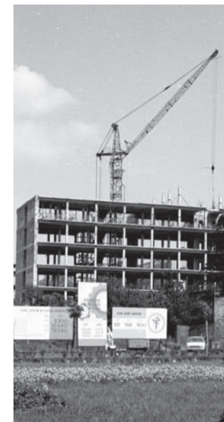
Budowa gmachu urzędu miasta zakończyła się w grudniu 1972 r. Początkowo budynek przeznaczony był dla firm gospodarki komunalnej. Nazywano go ON-Z-etem z powodu elewacji z aluminium i szkła.
