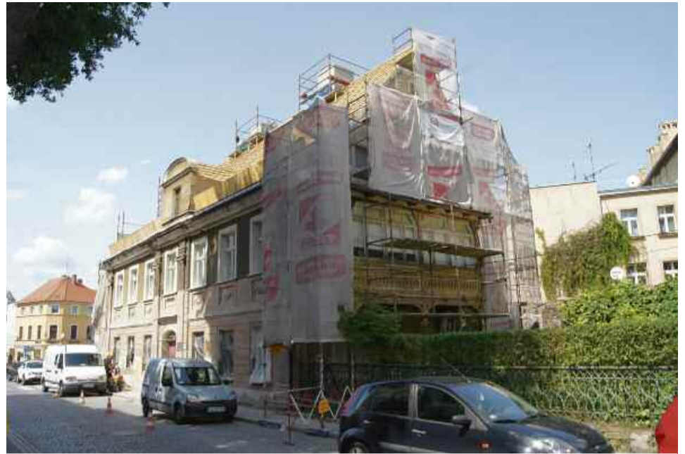
Widok współczesny. Trwa remont budynku, który powróci do pierwotnej elewacji
