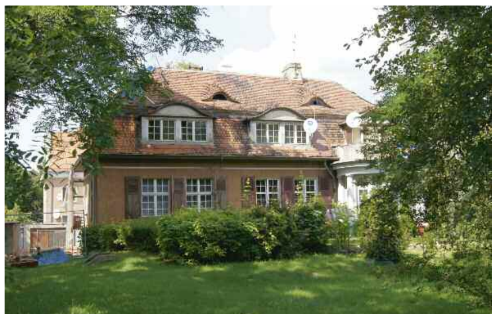
Dzisiaj budynek przy ul. Ułańskiej częściowo zastaniają drzewa
