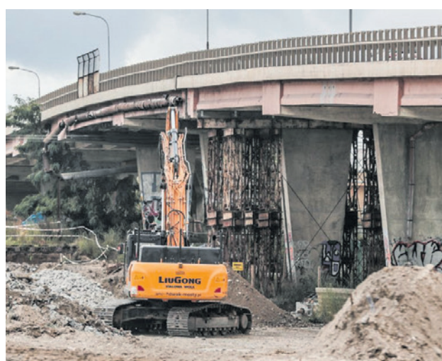
Prace przy ul. Zjednoczenia
