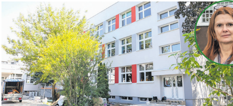
Budynek „piątki” podczas wakacji zyskał m.in. nową, piękną elewację w dwóch odcieniach szarości z czerwonym dodatkiem
