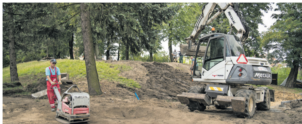
Trwają prace przy budowie ścieżki spacerowej. Powyżej, na niewielkim wzgórku stanie rzeźba Oskara Zięty. FOT. BARTOSZ MIROSLAWSKI
