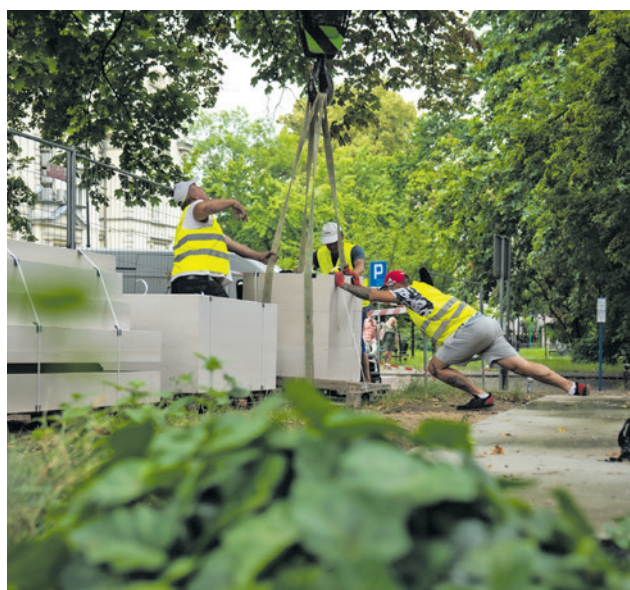
Elementy pomnika ważą ponad tonę. Do operacji podnoszenia potrzebny był dźwig.
