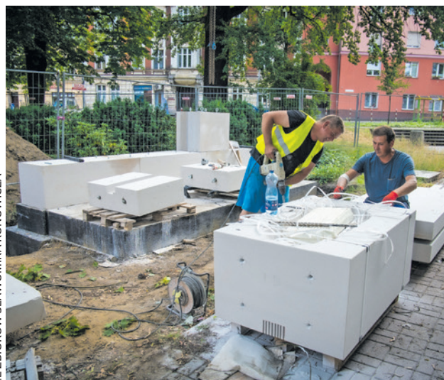
Pracownicy firmy Katanga ustawiają bloki z piaskowca
