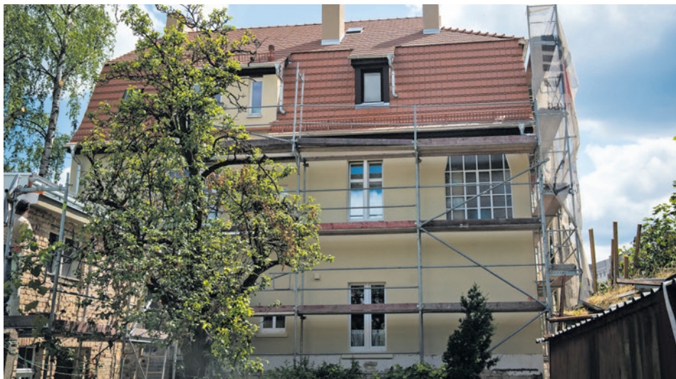
Najdroższe prace to te, które skończą się niebawem przy Sienkiewicza 38, kosztować będą 650 tys. zł
