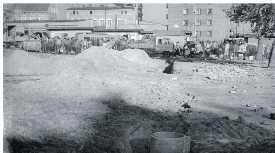
Targowisko przy Owocowej - przebudowa kanalizacji w 1988 r. FOT. BRONISŁAW BUGIEL
