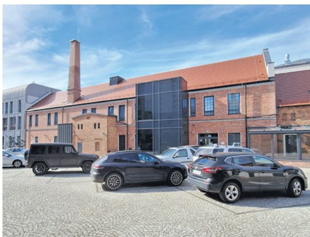
Widok współczesny. Zabudowania nad piwnicą zostały częściowo przebudowane. FOT. TOMASZ CZYŻNIEWSKI
