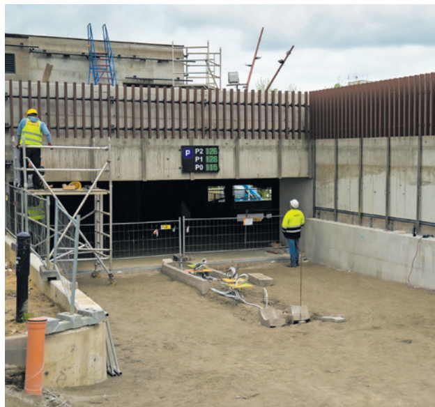
Brakuje jeszcze m.in. elewacji i balustrad zewnętrznych. Zainstalowano już nowoczesny system monitoringu zajętości miejsc na parkingu.
