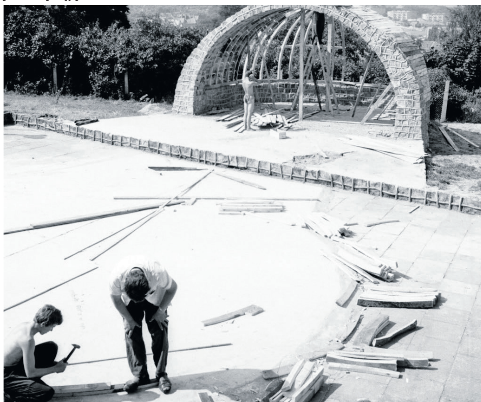
Lipiec 1967 r. - ostatnie prace przy budowie muszli i zagospodarowaniu terenu wokół Wieży Braniborskiej
