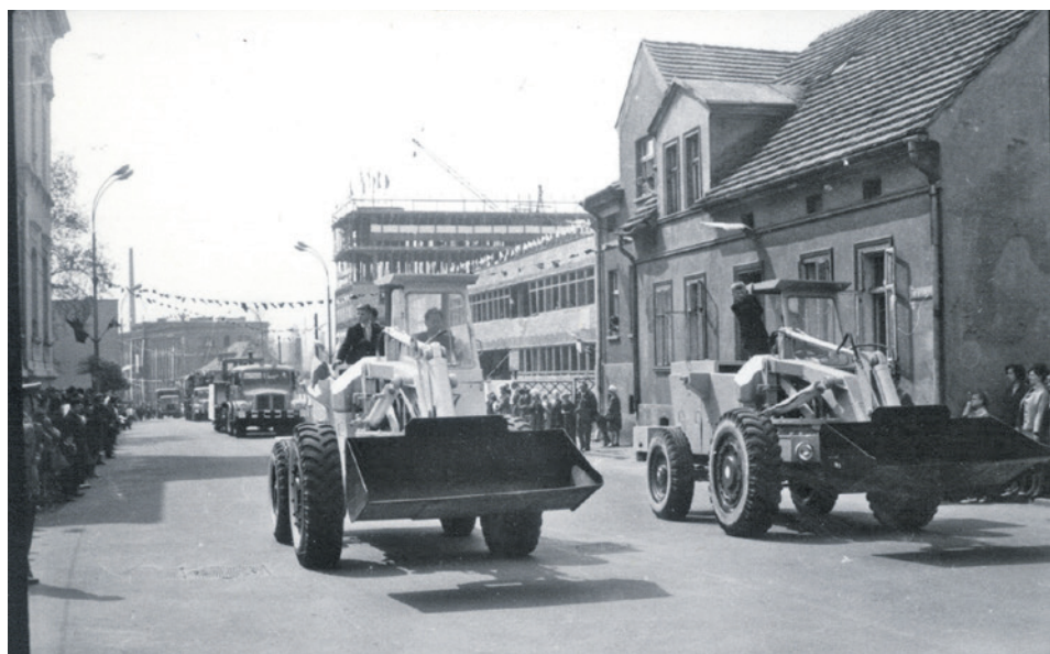
Pochód pierwszomajowy. W tle trwa budowa poczty (oddana do użytku w 1968 r.) oraz Klubu Międzynarodowej Prasy i Książki (oddany do użytku w 1969 r.). FOT. BRONISŁAW BUGIEL
