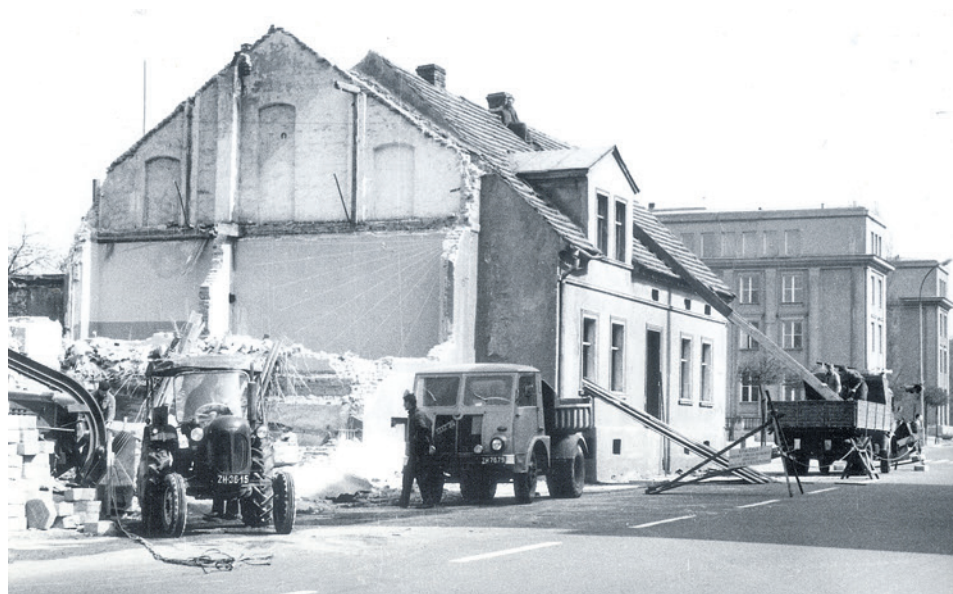
Trwa burzenie XIX-wiecznej kamieniczki, która wręcz „wchodziła” na poszerzoną ulicę. W tym miejscu w przyszłości stanie DT Centrum. FOT. BRONISŁAW BUGIEL
