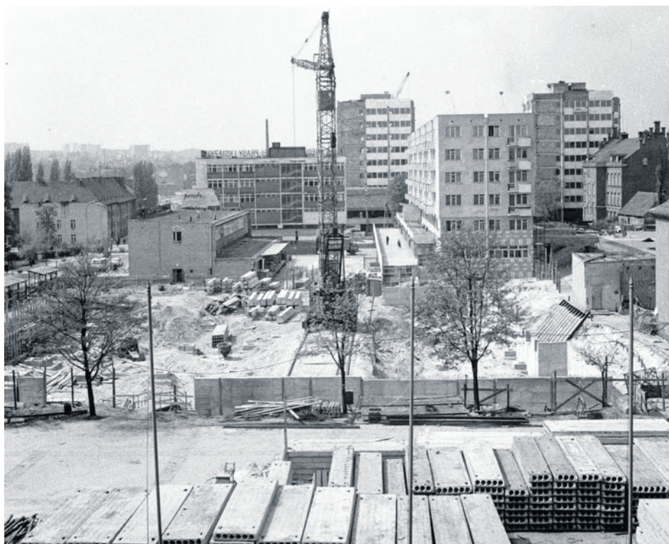
Fundamenty pod DT Centrum zaczęto wylewać w 1971 r. Wiosną 1972 r. rozpoczęto prace budowlane przy stawianiu budynku.
