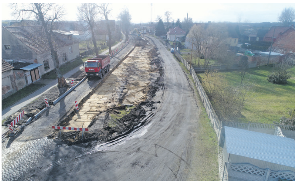
Budowana ścieżka widziana z lotu ptaka
