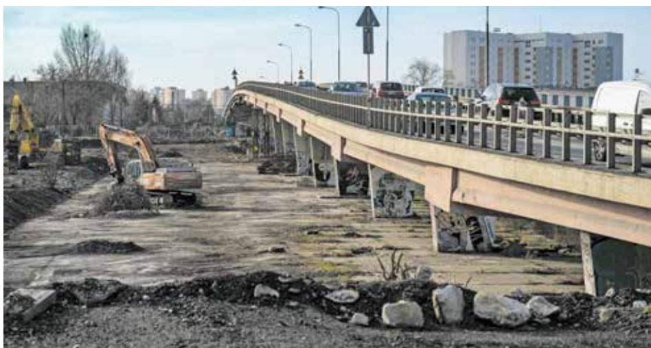
To nowy krajobraz okolic elektrociepłowni. Nie ma już śladu po wiadukcie wschodnim.
