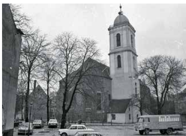
W miejscu zburzonej „Centralnej” powstał parking
