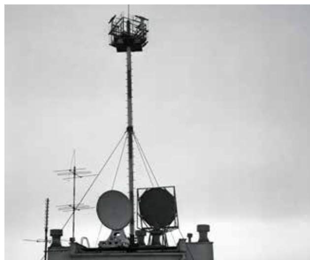
Antena na dachu wieżowca stała już w 1972 r.
