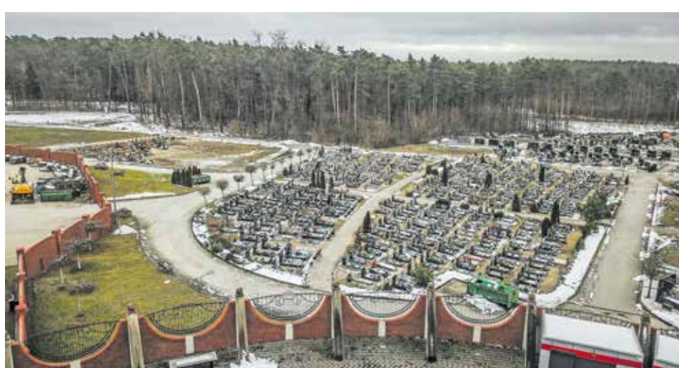
Na zapadanie się grobów szczególnie narażona jest nowa część cmentarza przy ul. Wrocławskiej
