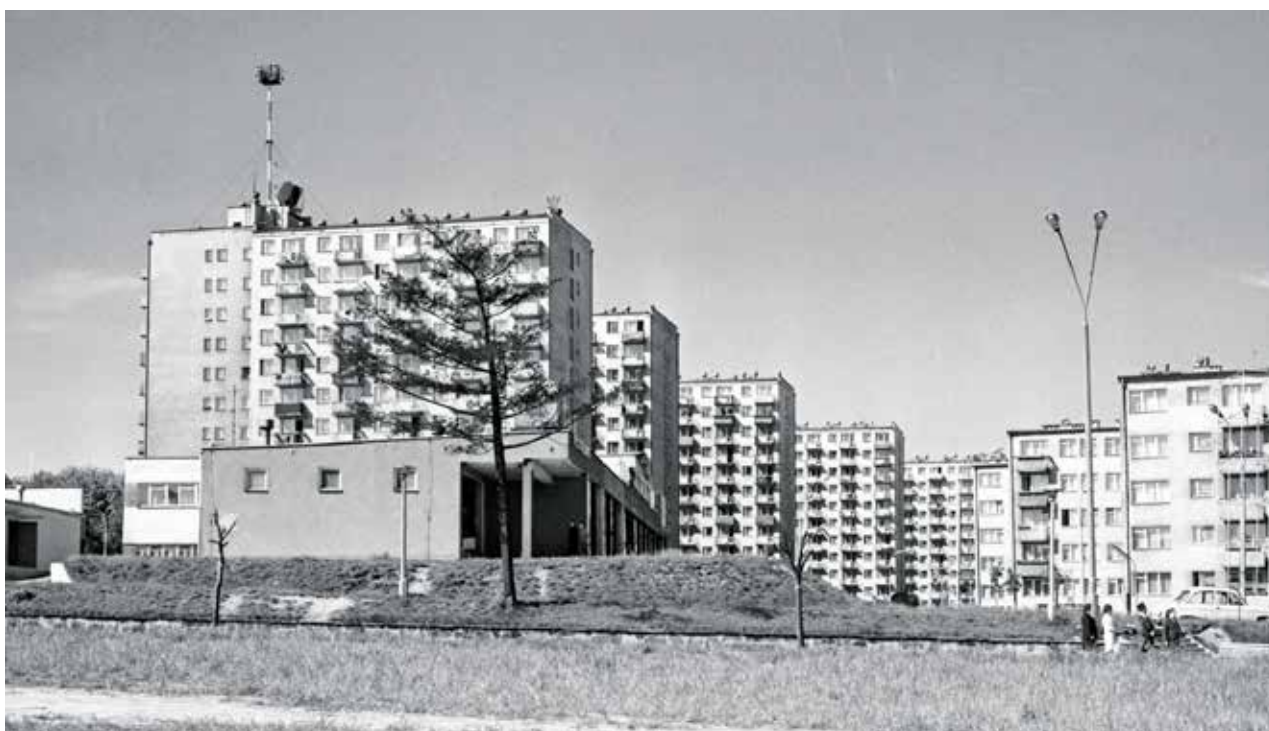
Wieżowce przy ul. Ptasiej górują nad okolicą, dlatego świetnie nadawały się do ustawienia na nich nadajnika telewizyjnego
