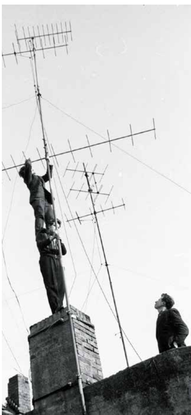
Na dachach domów pojawił się las anten. Ich montaż wymagał od robotników cyrkowych umiejętności. Nie miało to nic wspólnego z zasadami BHP.
