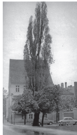
To samo miejsce w 1980 r.
