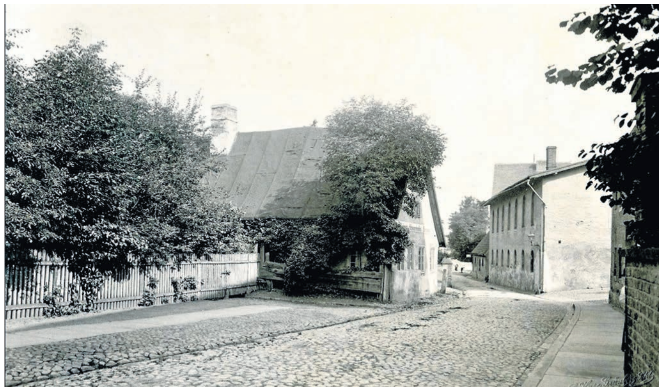
Dawna Hospitalstrasse, czyli dzisiejsza ul. Moniuszki - widok z 1913 r. Budynek po prawej to dawny szpital, w tamtym czasie hala sportowa.
