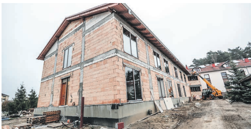
Ekipa budowlana idzie jak burza. Nowe skrzydło zakładu pielęgnacyjno - opiekuńczego przy ul. Prostej ma już dach i okna.
