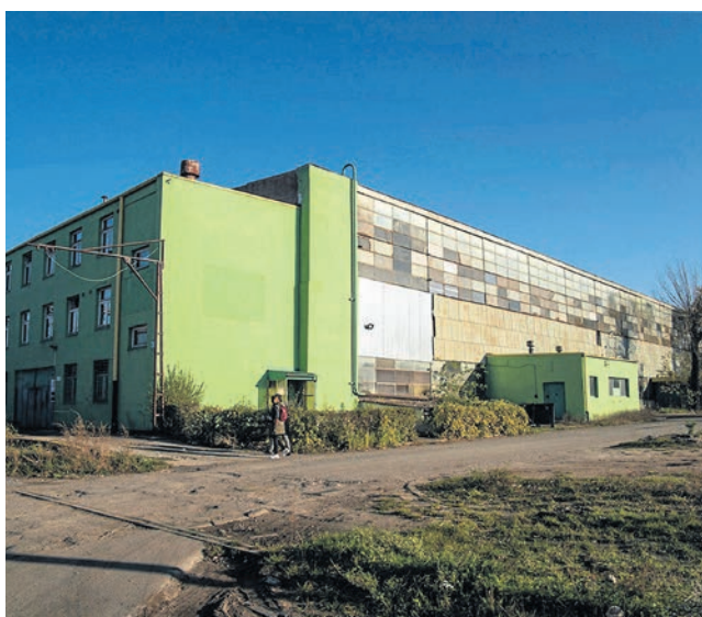
Hale przedsiębiorstwa na terenie Zastalu już opustoszały
