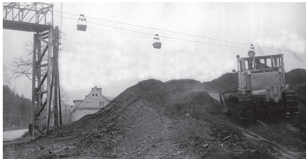
Kopalnia w Sieniawie w 1983 r. Część urobku transportowano w podwieszanych wagonikach.
