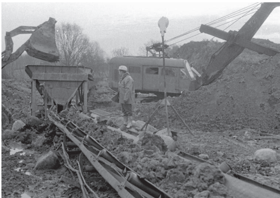
Kopalnia w Sieniawie w 1983 r. Część odkrywkowa - trwa załadunek na taśmociągi.
