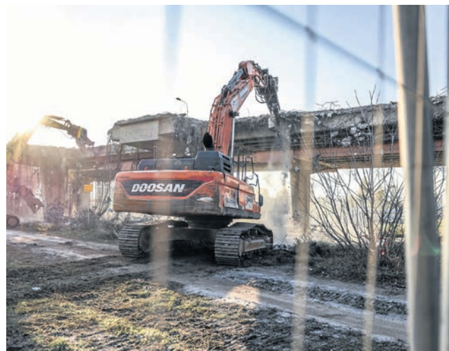
Na wiadukcie przy ul. Zjednoczenia zaczęła się wielka demolka!
