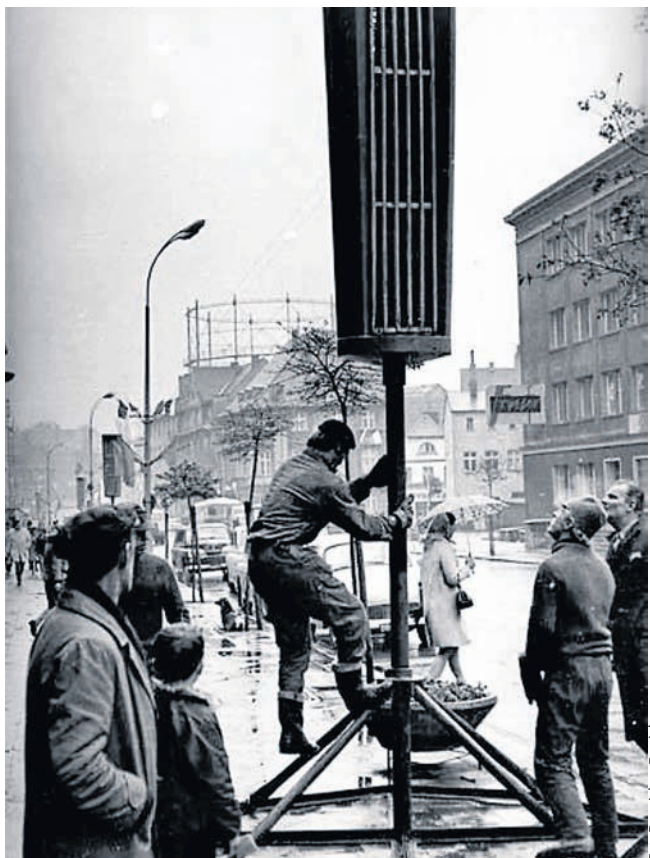
Ustawianie megafonu przy ul. Bohaterów Westerplatte. Z tułu widoczna gazownia.
