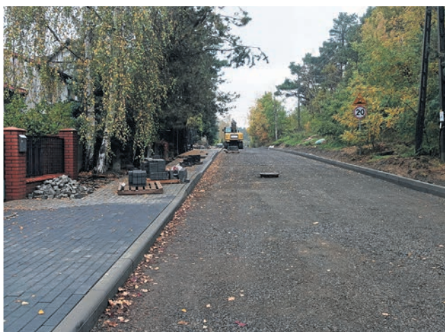
Na ul. Przewalskiego jest już podbudowa z kruszywa, są obrzeża i krawężniki betonowe
