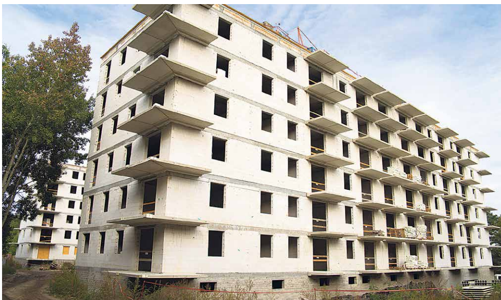
Powstaje pierwszy blok na osiedlu Leśny Dwór. Będzie miał 180 mieszkań.
