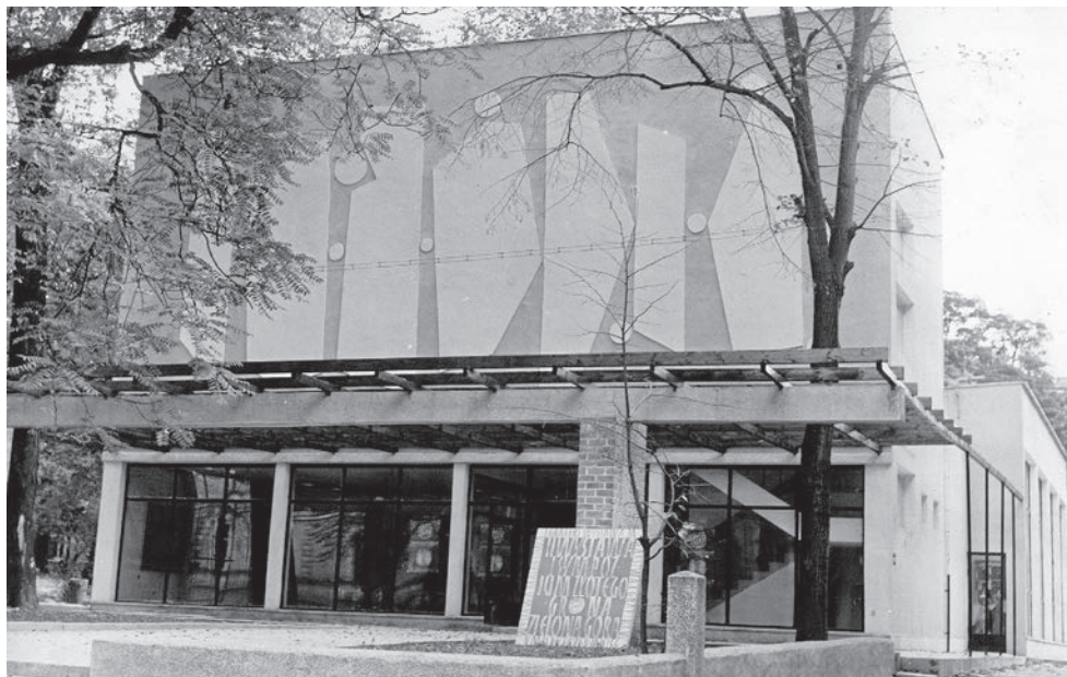
Budynek BWA - na ścianie frontowej relief Szpakowskiego z 1965 r.
