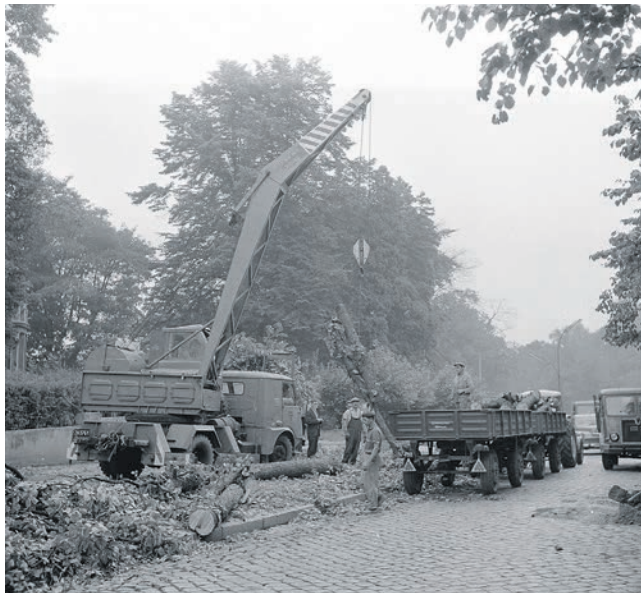
Trwa usuwanie wyciętych drzew rosnących przy ul. Chrobrego
