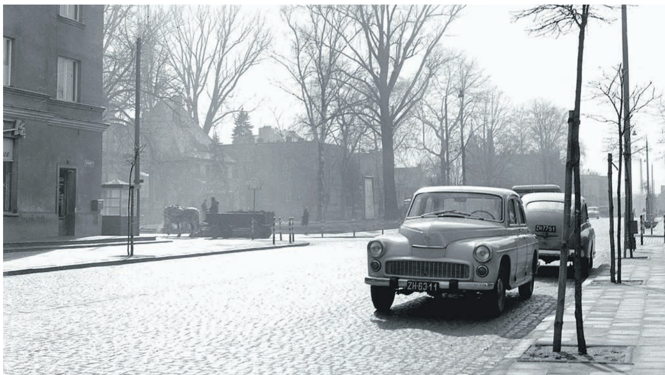
Ul. Bohaterów Westerplatte - skrzyżowanie z ul. Ułańską jeszcze przed położeniem asfaltu
