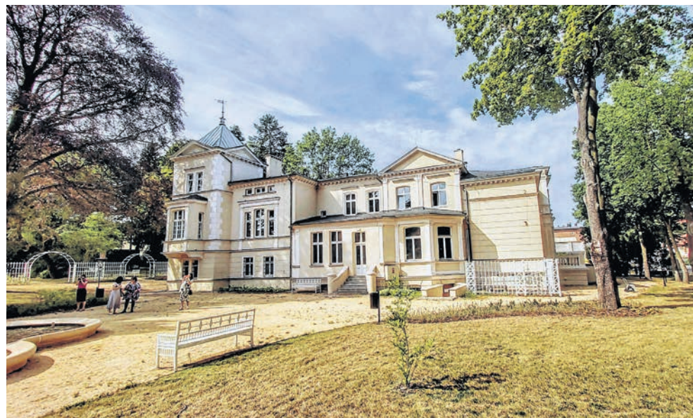
Widok współczesny od strony skrzyżowania ul. Sienkiewicza i Stromej
