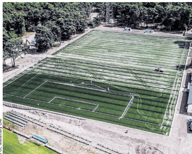
Boisko już jest. Niebawem przykryje je dach.
