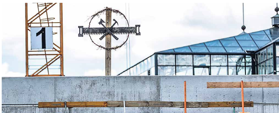
Symboliczny wieńiec oznacza, że gotowa jest konstrukcja budynku i szkielet przykrycia obiektu
