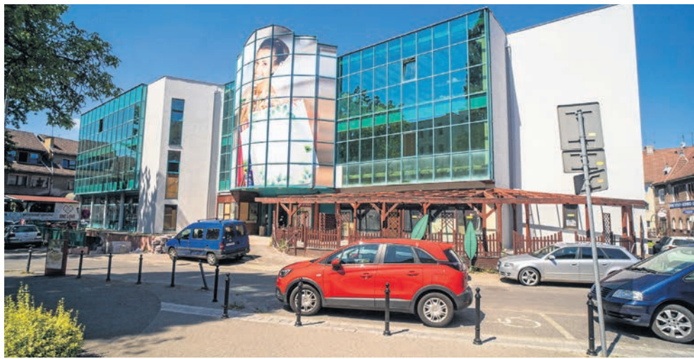
W budynku trwa remont. Według ostrożnych zapowiedzi, pierwsze zakupy zrobimy tu prawdopodobnie jesienią.
