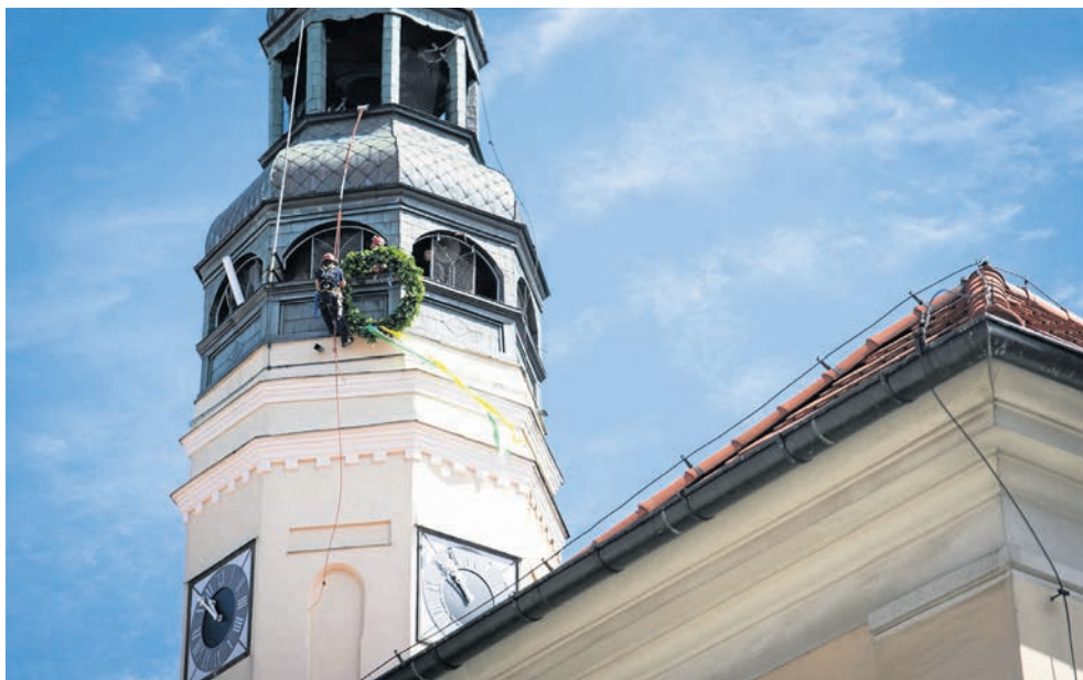
Żeby umocować wieniec na wieży, alpinści musieli się opuścić na linach
