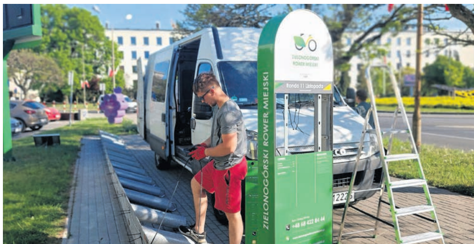
Montowanie stacji rowerowej przy rondzie 11 Listopada
