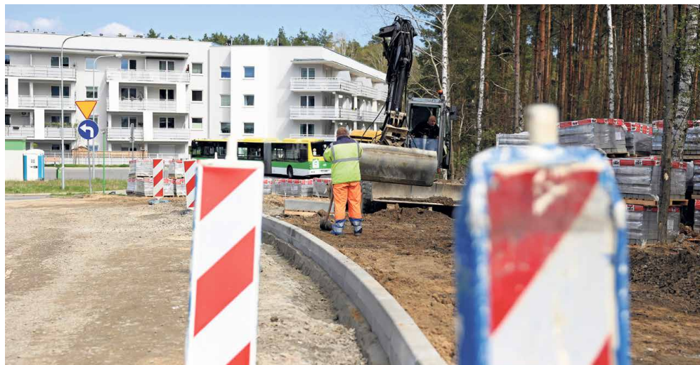
Bud-Dróg układa już krawężniki pod przyszłą drogę
