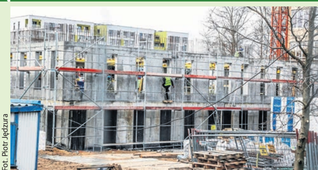
Powstają kolejne piętra budynku edukacji artystycznej
