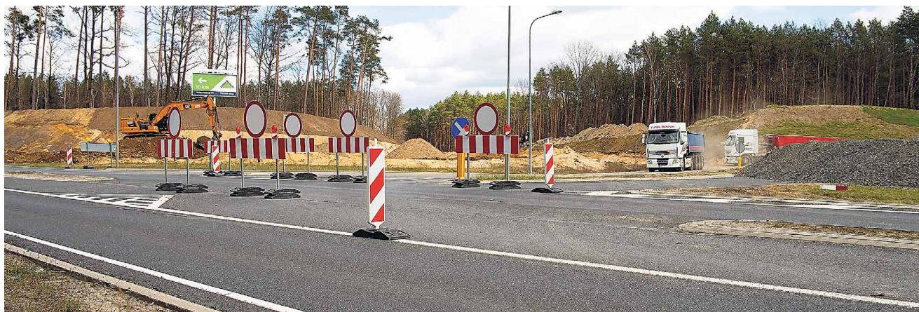
Najwięcej utrudnień w ruchu powoduje budowa ronda pomiędzy Wilkanowem i Świdnicą. Tutaj obwodnica południowa połączy się z drogą krajową nr 27.
