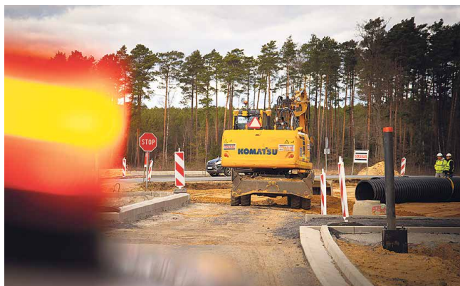
Firma Strabag buduje rondo z Jędrzychowa do Zatonia
