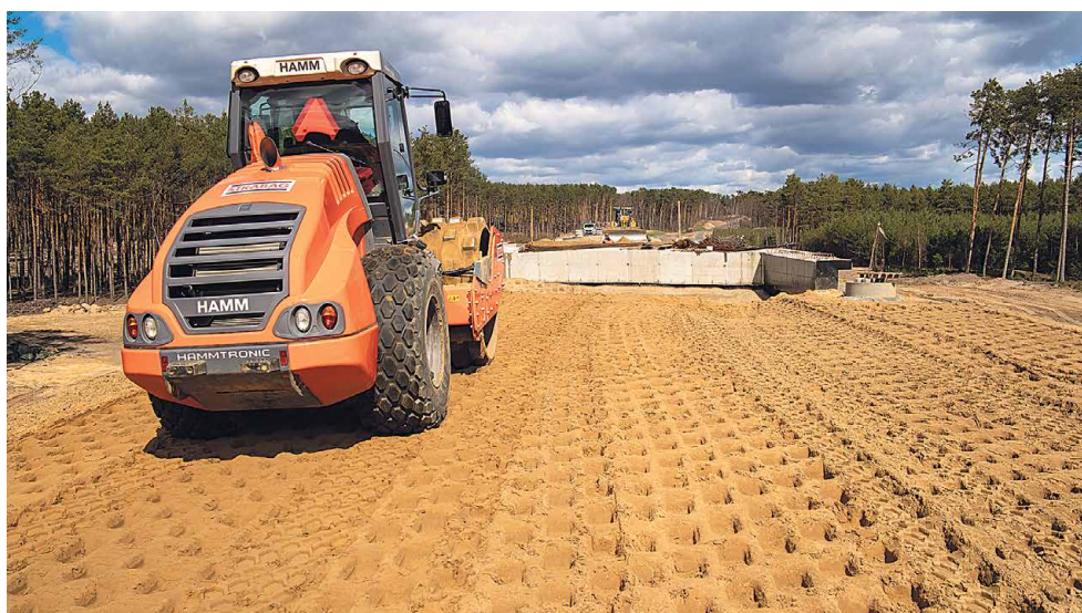
Trwa mechaniczna stabilizacja podłoża przy przyczółkach wiaduktu pomiędzy Raculą a Jędrzychowem
