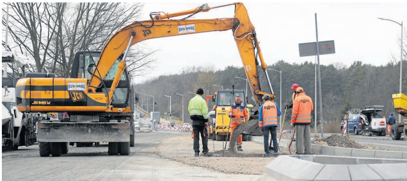
W ostatnich tygodniach na placu budowy można zauważyć duże przyspieszenie
