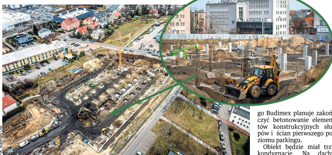
Widać już zarys parkingu. Najbardziej zaawansowane są roboty budowlane w części obniżonej pierwszego poziomu, od strony urzędu marszałkowskiego.
