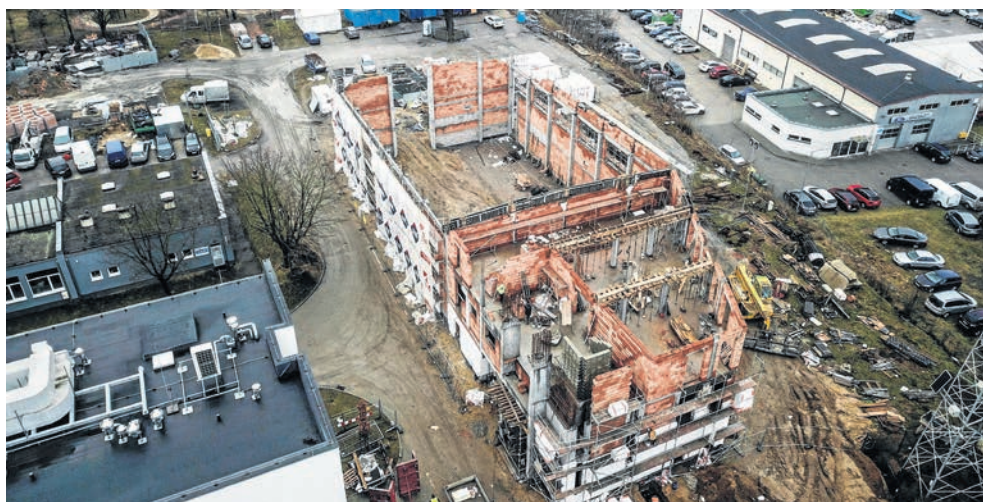
Widać duży postęp na placu budowy hali sportowej przy ul. Energetyków
