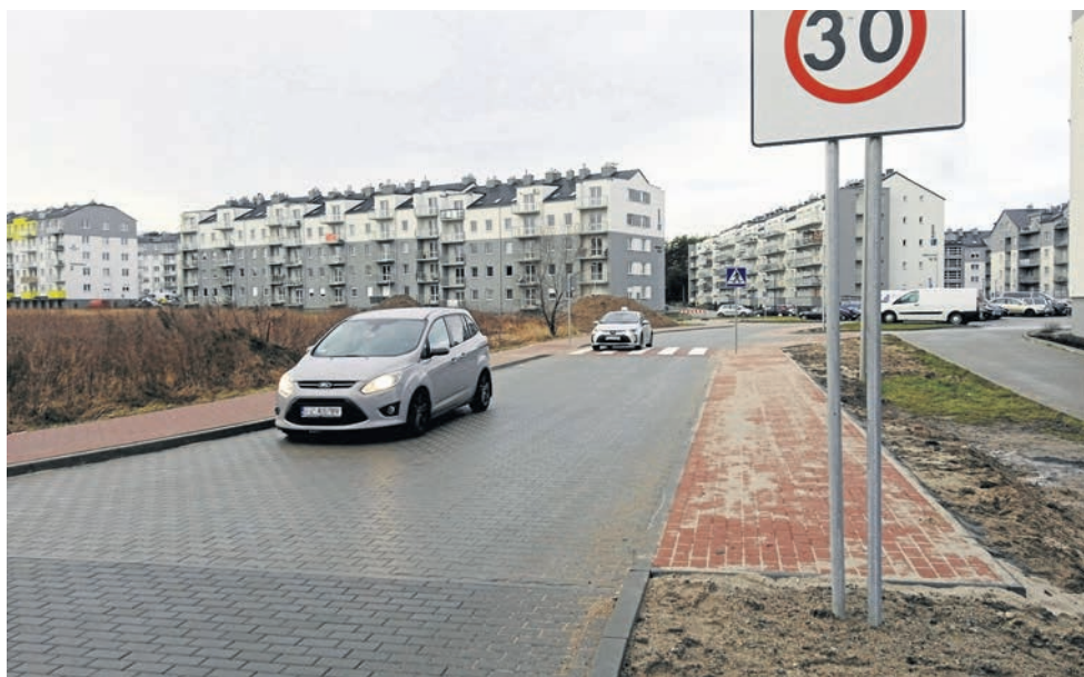
Przy ul. Inwestycyjnej zakończył się pierwszy etap modernizacji drogi osiedlowej i od razu rozpoczął kolejny
