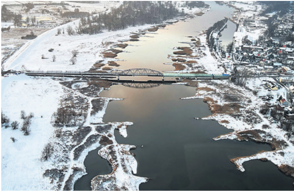
Do finału remontu brakuje już niewiele. Teraz budowlanci montują oświetlenie i sterowanie ruchem, układają chodniki i ścieżkę rowerową.
