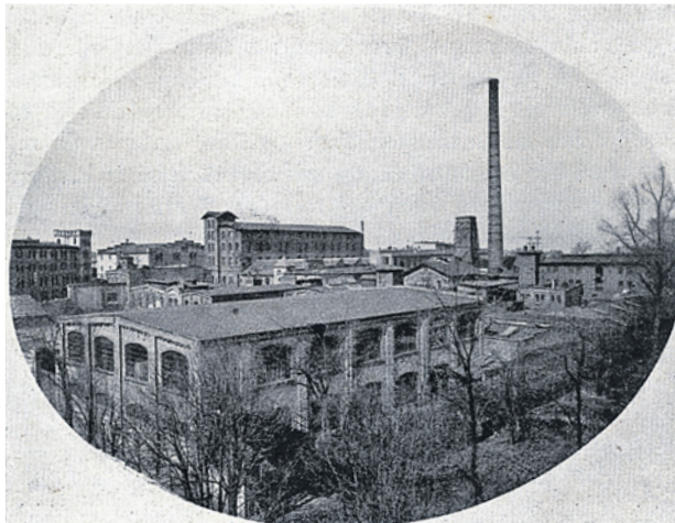
XX wiek - widok na fabrykę od strony ul. Ogrodowej/Sikorskiego
