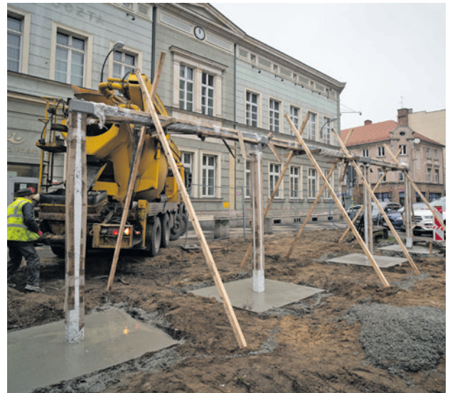
Na konstrukcji przed pocztą zawisną huśtawki. Skwer ocieplą miłośnicy. FOT. BARTOSZ MIROŚLAWSKI
