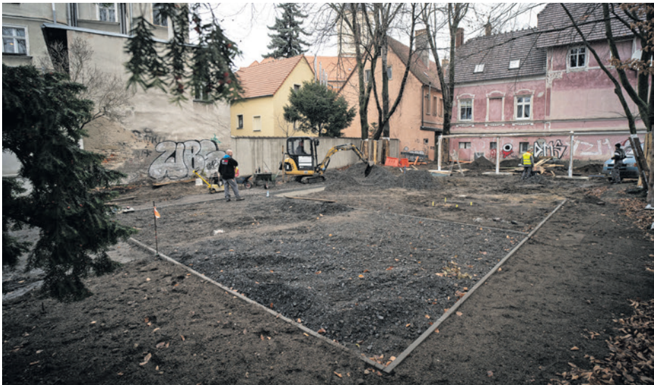
Marzenie przybiera realny kształt. W tym miejscu będzie zielony, przyjazny mieszkańcom skwer, w którym każdy będzie mógł „zaszyć się” choć na chwilę. FOT. BARTOSZ MIROSLAWSKI
