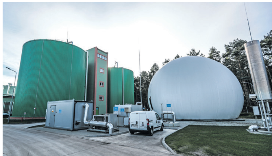
Oczyszczalnia ścieków poszerzyła się o biogazownię, która będzie produkować prąd na potrzeby zakładu
