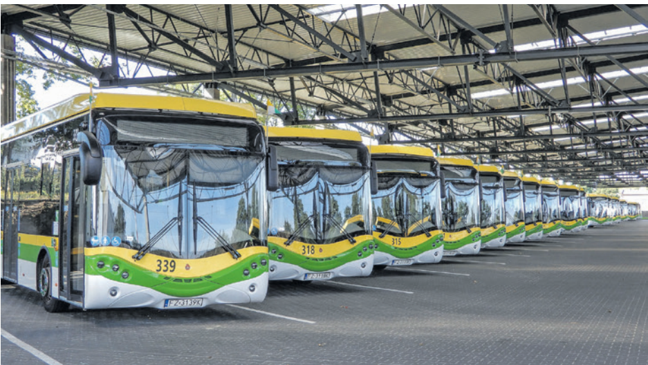
Wszystkie autobusy MZK parkują pod wielką wiatą. Jej dach jest przystosowany do zamontowania paneli fotowoltaicznych.
