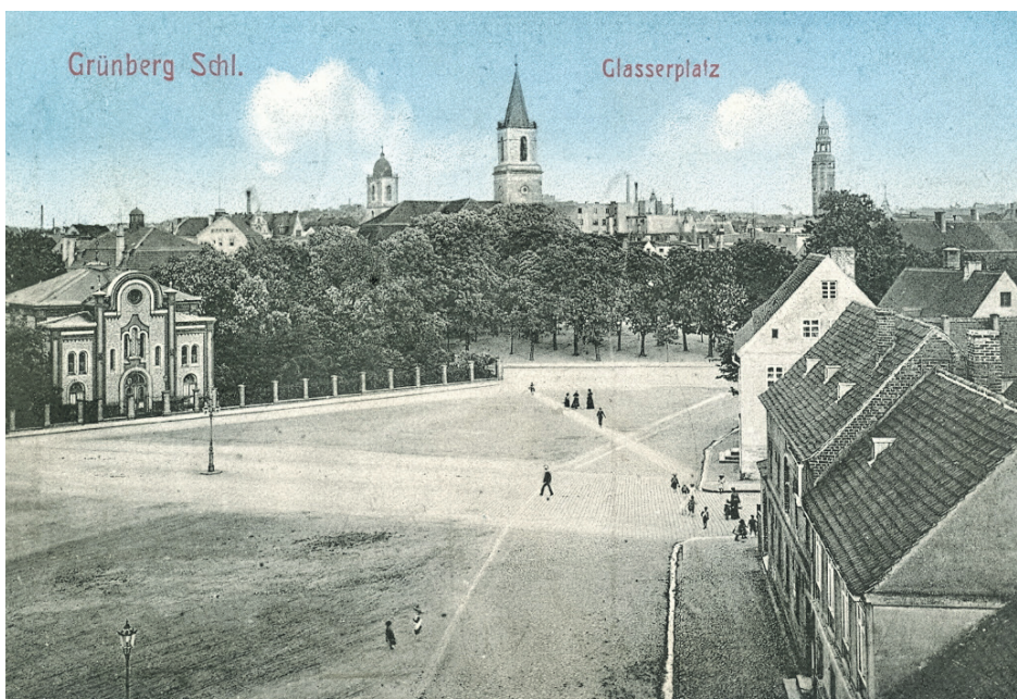
Glasserplatz - dzisiejszy pl. Powstańców Wielkopolskich. Po lewej stronie budynek synagogi, po prawej wylot ul. Reja. ZE ZBIORÓW SŁAWOMIRA RONOWICZA
