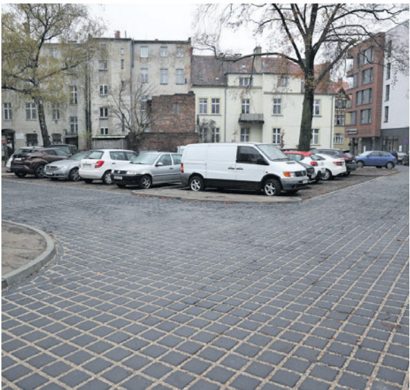
Przez taką kostkę woda przesiąknie i wniknie w grunt
