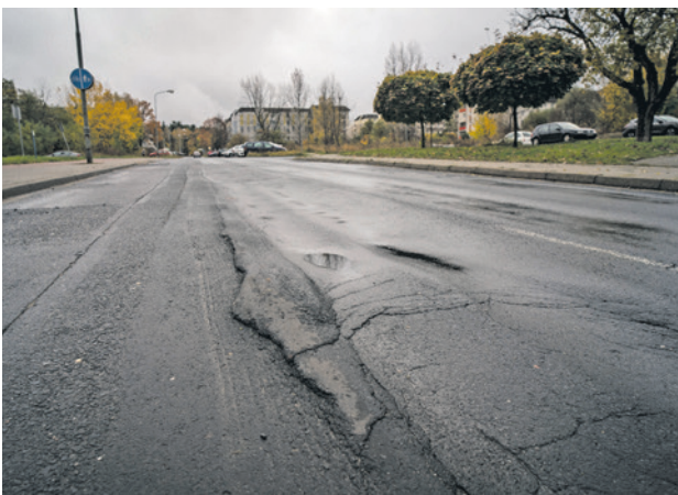
Nawierzchnię ul. Osiedle Śląskie zniszczył m.in. ciężki sprzęt
