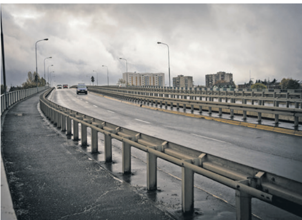
Poprawiana będzie wschodnia jezdnia wiaduktu na ul. Zjednoczenia
